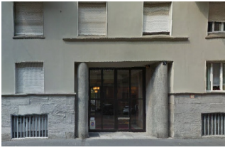
CONDOMINI VIA BANDELLI 6 e 8 MILANO
